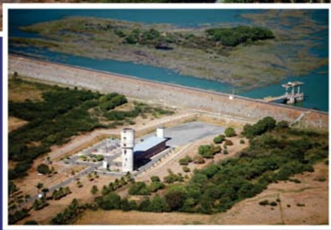
Tomada e elevação das águas da represa de Sobradinho
