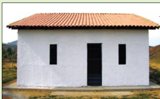
FIGURA 4 Casa pré-moldada de bambu, construída em Três Rios, RJ, com 41 m 2
