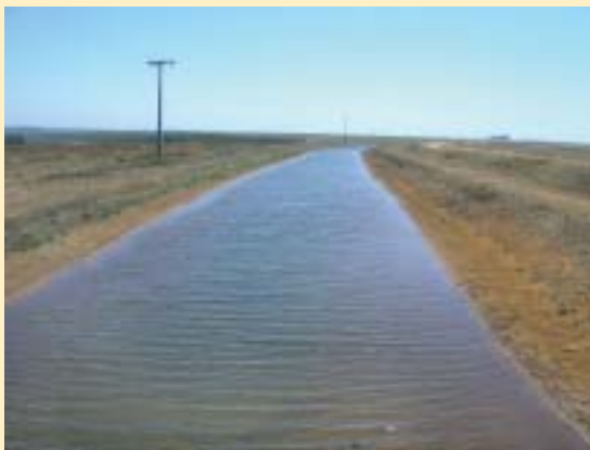
Canais ligam as represas a reservatórios menores de água
