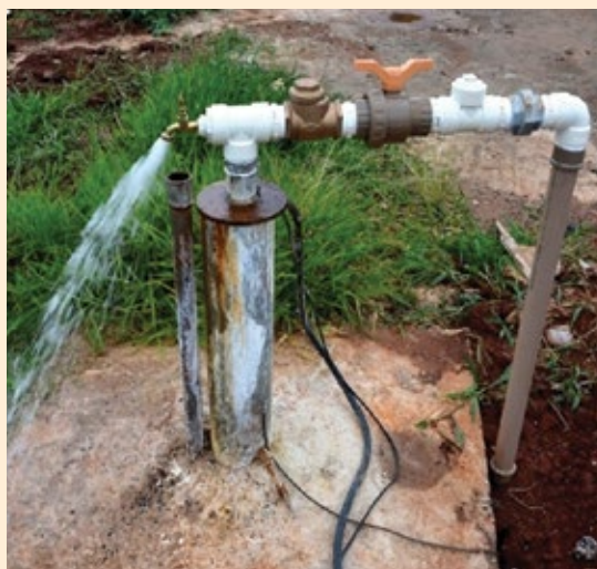
Poço artesiano construído para abastecer o Distrito de Taquari-Ponte em Leme (SP)
