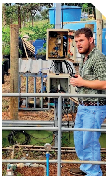
Figura 3 – Painel de controle e integração hidráulica do sistema de irrigação fuzzy -IoT
