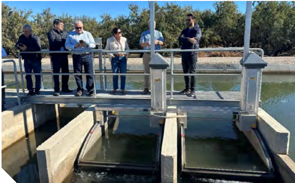
Figura 9 – Comporta de operação automática para vazão constante
