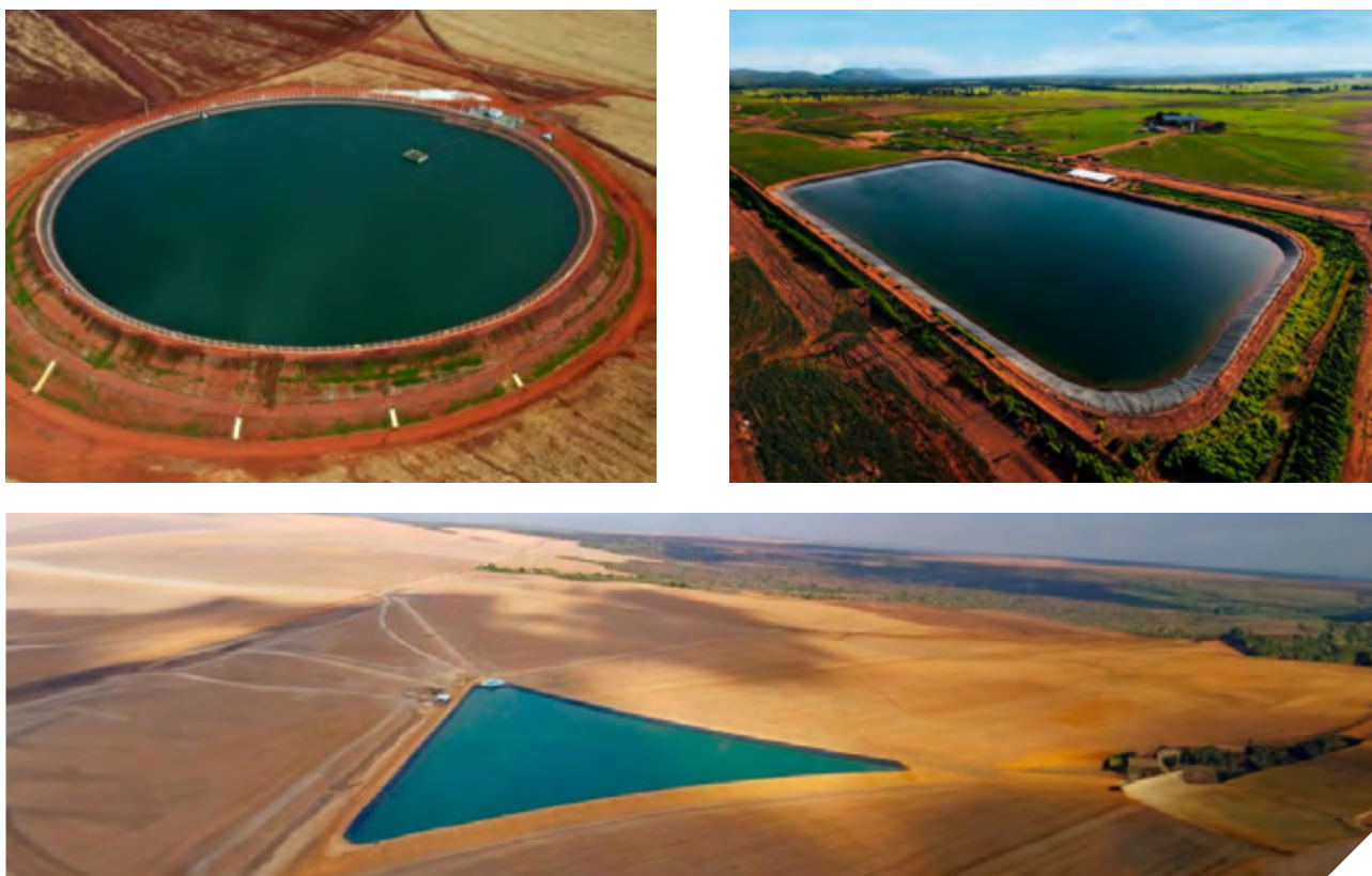
Figura 1 – Vista aérea de reservatórios de grande porte para apoio à irrigação por pivô central
