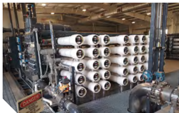
Figura 5 – Filtros de osmose reversa
