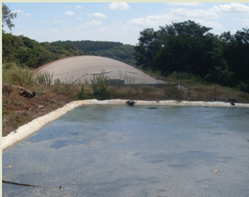
FIGURA 9 – Efluente do biodigestor, conhecido como biofertilizante, é aplicado via sistema de irrigação – Foto: Caciano Mafioletti
