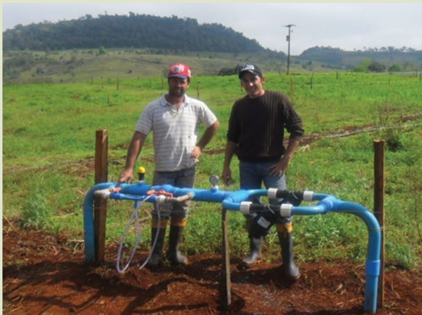
FIGURA 3 – Claudirlei Grassi e instalador da IrrigaRural, Evamor, no cavalete de filtragem e injeção de fertilizantes – Foto: Juliano Alarcon
