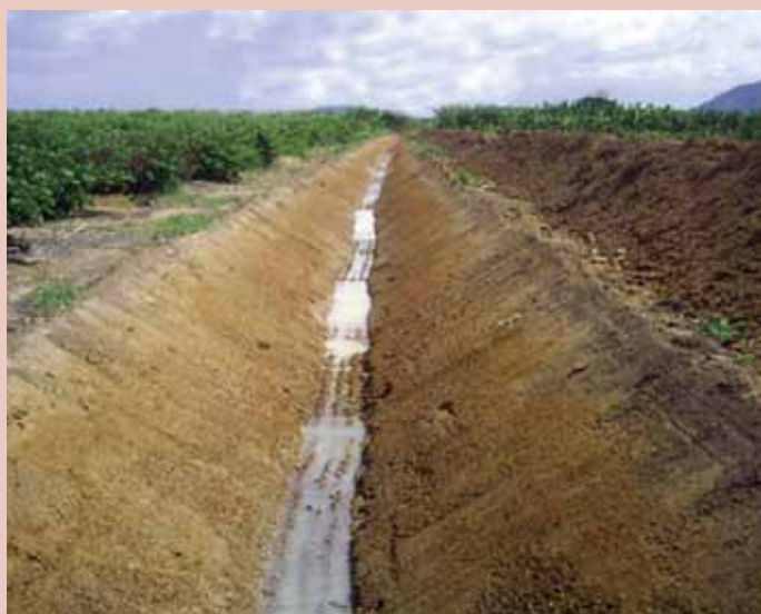
Drenagem superficial no Perímetro Irrigado Brígida, PE
