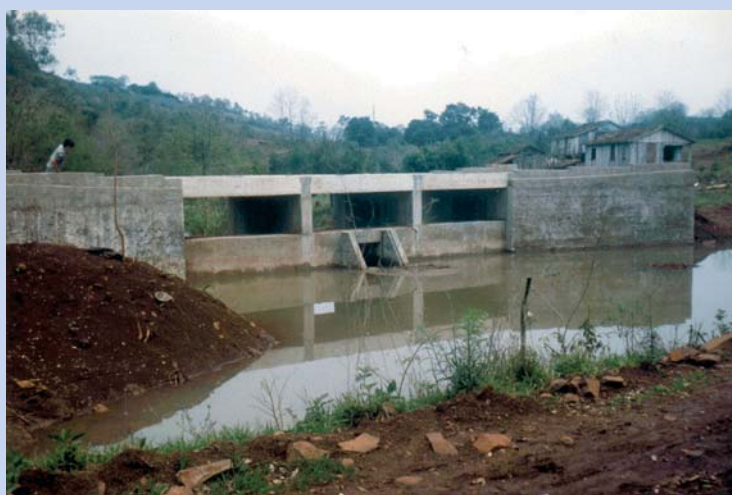
FIGURA 20 – Barragem-ponte construída na região do Planalto
