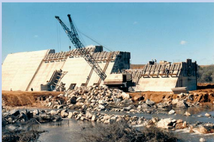
FIGURA 19 – Barragem no Rio Vacacaí – VAC – 04 – Em construção
