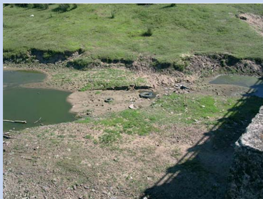
FIGURA 15 – Ponte na BR – 293, em Dom Pedrito, RS em janeiro de 2005
