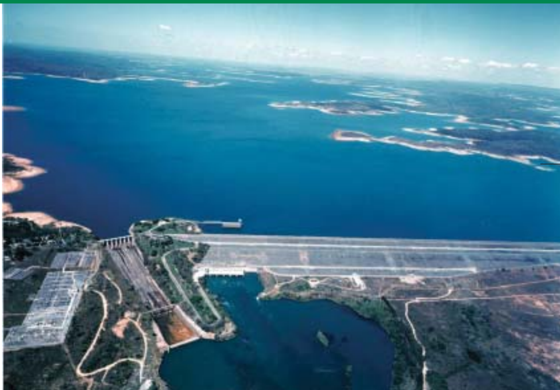
Vista aérea da Barragem de Três Marias, em Minas Gerais. Os usos múltiplos incluem a melhor regularização das vazões à jusante
