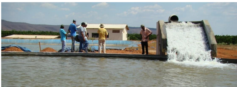
Figura 13. Escada de aeração e depósito decantador (Fazenda Santa Elisa II – Pirapora, MG).
